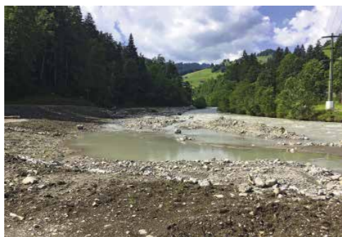
Vom ersten Aushub bis zur Bauabnahme.
