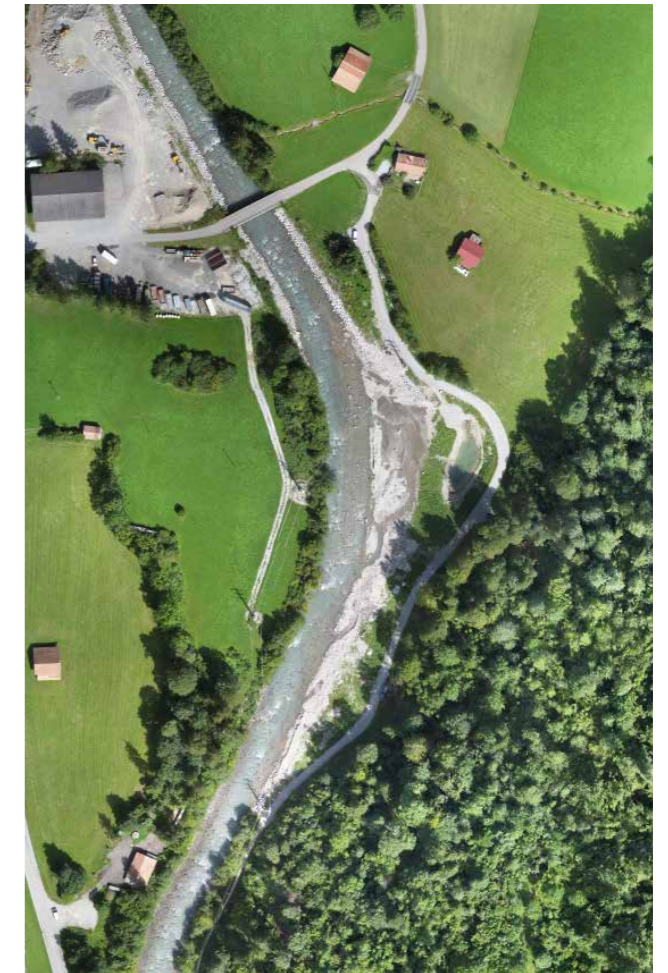
Nach Durchführung der Arbeiten (Stand August 2017).
